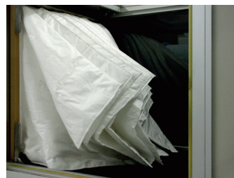
Abb. 1: Wenig eigenstabiles, herkömmliches synthetisches Taschenfilter
